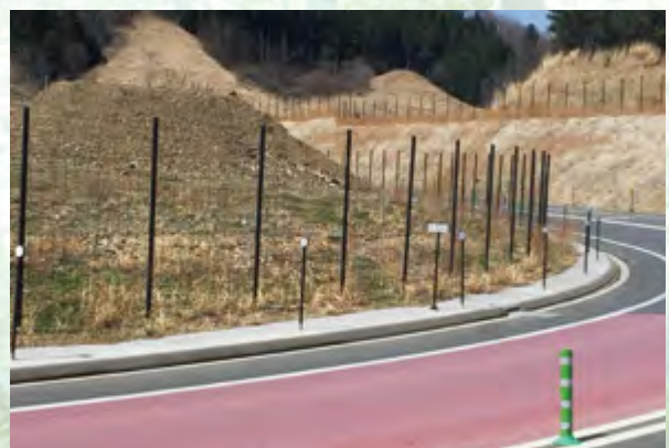
道路の立入防止柵
